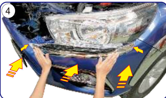
POSITION DRL TO MOUNTING POSITION AS SHOWN. นำ DRL ทาบกับบริเวณที่ติดตั้งโดยให้ขอบของชิ้นงาน เข้ากับส่วนโค้ง ดังภาพ
