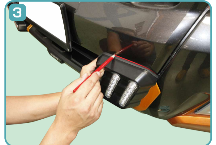
MARKING TO DRL MOUNTING POSITION WITH USING CRAYON. กำหนดตำแหน่งการติดตั้งดวงไฟ DRL โดยใช้นิ้วดินสอเทียน
