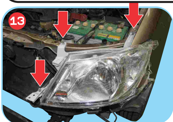
ยึดน็อตดวงไฟด้านบนทั้ง 3 จุด
